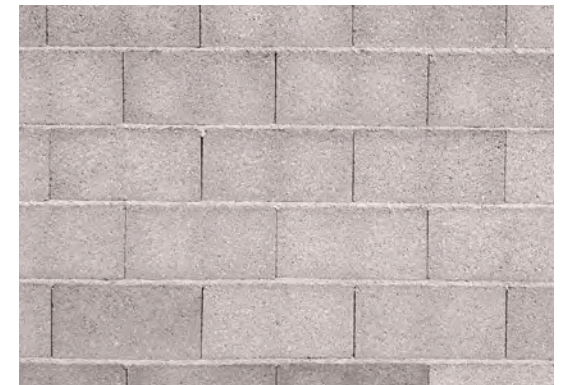
Preparazione del supporto
